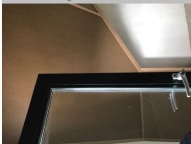
Dak interieur - Knieschotten
